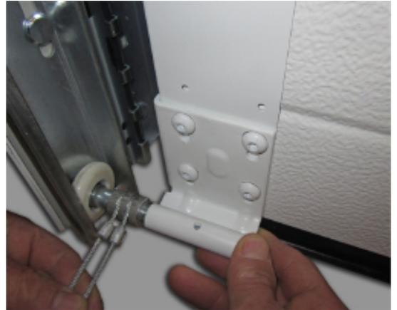
3 - Positionner le panneau inférieur en introduisant la roulette dans la console de base
