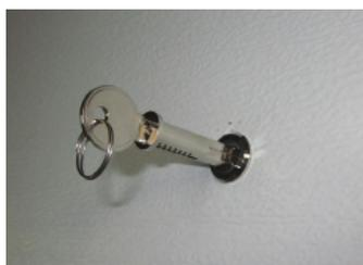
Côté intérieur, attacher la cordelette au barillet
