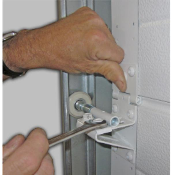
En appuyant la roulette vers le bas, serrer les 2 vis de blocage du porte roulette supérieur et figer la position par 2 vis en partie basse de la pièce
