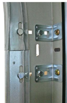
A l'aide de boulons M8 et de 2 équerres de maintien , fixez le profil C derrière le rail horizontal
